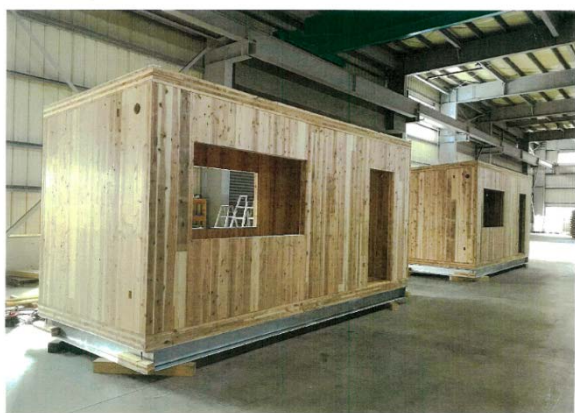
CLT躯体（外装仕上げ前）
