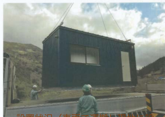
設置状況（車両で運搬し現地に設置）
