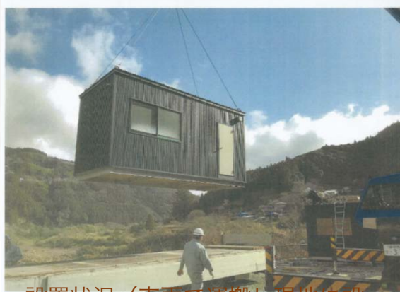
設置状況（車両で運搬し現地に設置）
