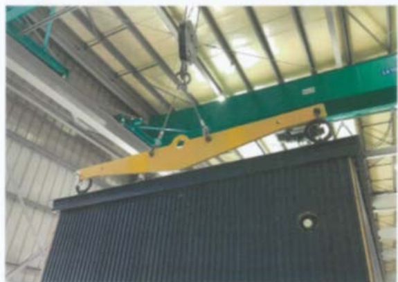
設置（吊り下げ治具使用）
