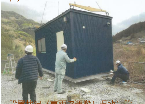
設置状況（車両で運搬し現地に設置）
