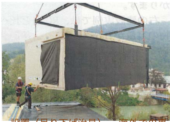
設置（吊り下げ治具） 海外での事例
